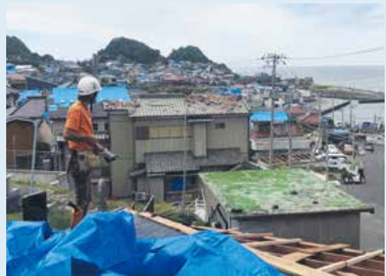
館山市内 修理中の屋根から
