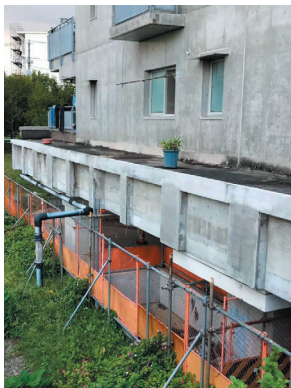
撤去されたG棟
